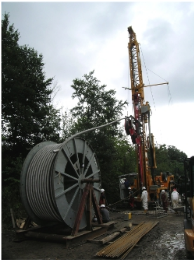
Einbau des Edelstahlwellrohrs beim Projekt
