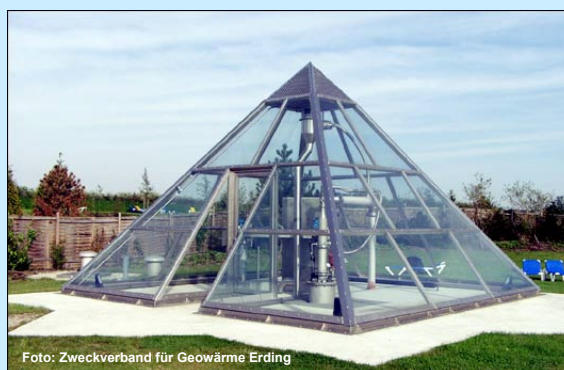
Bohrlochkopf am Standort Erding
