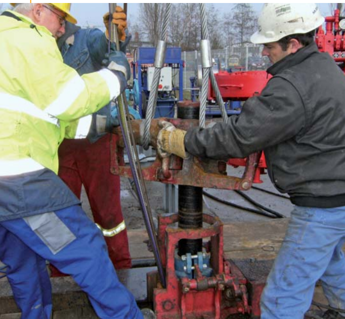
Einbau der Thermalwasser-Förderpumpe
