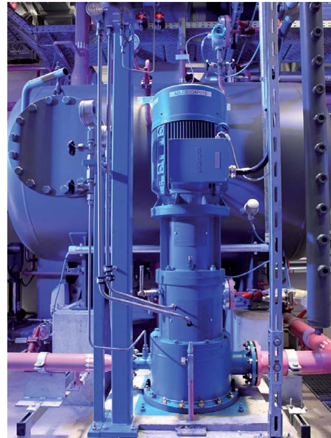
Umwälzpumpe Kalinakreislauf
